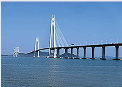
대통령상 수상작 ‘천사대교(암해~암태) 제1공구 건설공사 출처: 국토교통부, (2020). 2020 대한민국 국토대전...신안군 ‘천사대교’ 대통령상 수상, 7월 16일 보도자료.
